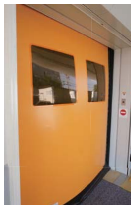
陽圧システムを導入した倉庫
